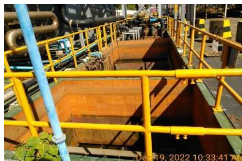
ภาพที่ 2-8 บ่อดักคราบน้ำมัน (Oil interceptor)
