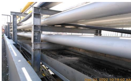
ภาพที่ 2-2 ถาดรองรับน้ำมันที่อาจรั่วไหลจากการถอดและเชื่อมต่อในการขนถ่ายน้ำมันที่ท่าเรือ
